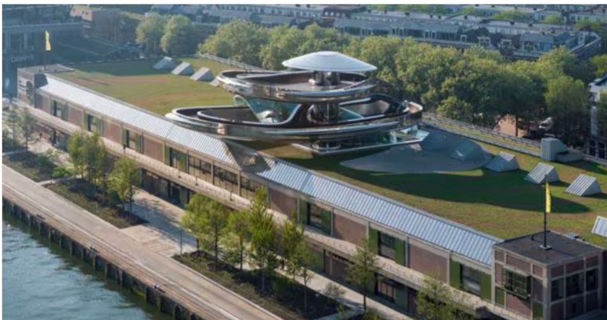
▲ Fenix è stato costruito in otto anni di lavoro all'interno del magazzino portuale San Francisco, fino a pochi anni fa abbandonato ma negli anni Venti uno dei più grandi al mondo (foto di Iwan Baan).
